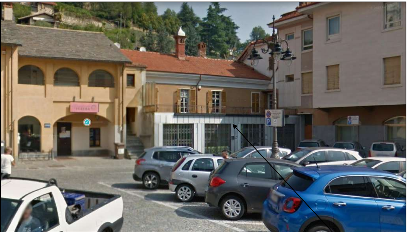
Vista in direzione nord da Via Roma , indicato il corpo di fabbrica costituente superfetazione
