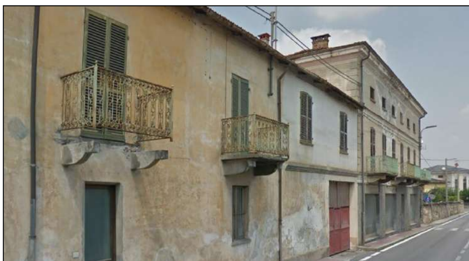
Vista in direzione nord da Via Matteotti
