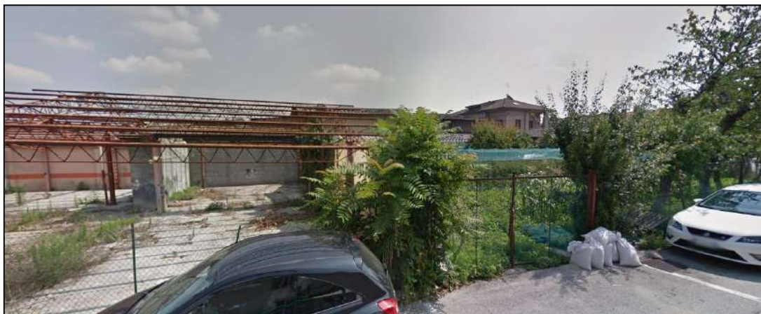
Vista dell'area oggetto di modifica verso est da Via Vecchia di Cuneo (porzione sud)
