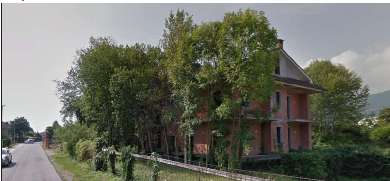
Vista dell'area oggetto di modifica verso sud-ovest da Via Torino
