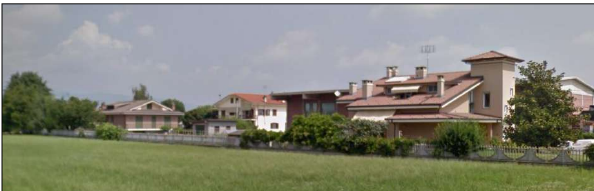
Vista dell'area oggetto di modifica verso nord da Via Camposanto
