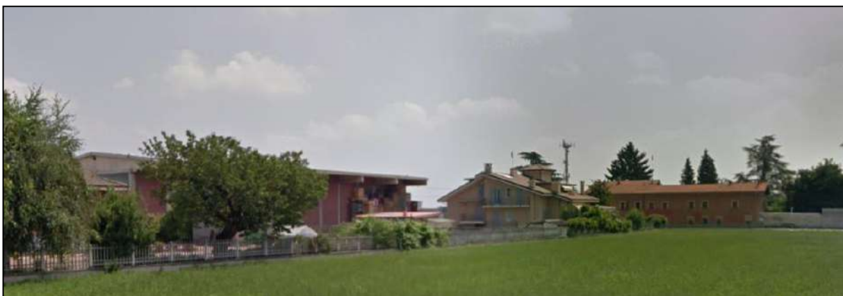
Vista dell'area oggetto di modifica verso est da Via Rittanolo
